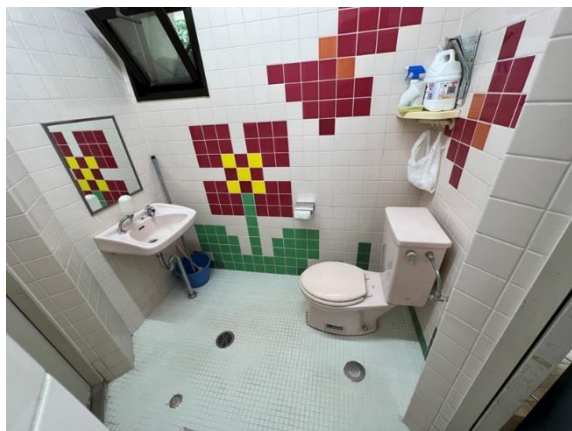
図3 床が水洗い可能なトイレ
